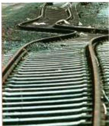
Effetti di un terremoto sull'allineamento dei binari ferroviari
